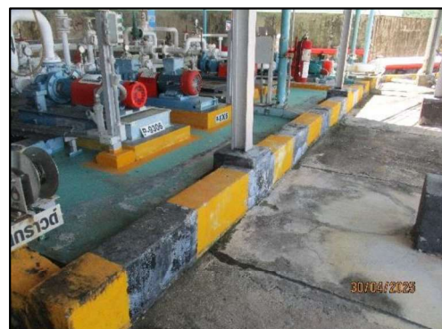
ภาพถ่ายที่ 2.2-3 คั่นคอนกรีต (Bund Wall) ล้อมรอบปั๊มและคอมเพรสเซอร์
