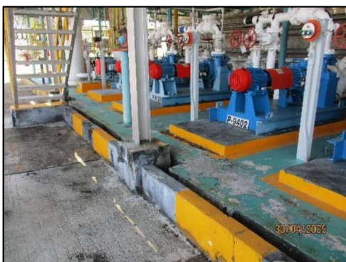
ภาพถ่ายที่ 2.2-3 คั่นคอนกรีต (Bund Wall) ล้อมรอบปั๊มและคอมเพรสเซอร์
