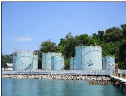
ภาพถ่ายที่ 2.2-1 ถังเก็บน้ำมันสำรองประเภท Floating Roofs
