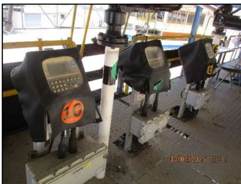
ภาพถ่ายที่ 2.2-2 การติดตั้งระบบการจ่ายน้ำมันแบบอัตโนมัติ (Terminal Automation System/TAS)
